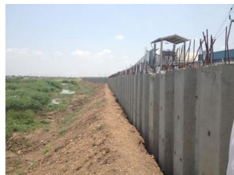
로자나공단지역에 건설중인 독과 방수벽 (건설개시 당시, 그 구조가 잘 보이도록 촬영)
